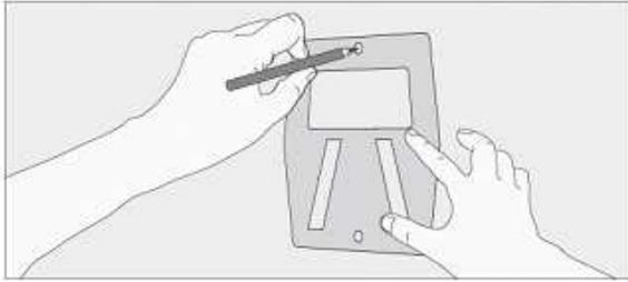
En la ubicación determinada anteriormente presentar el soporte que va al muro y marcar dónde irán los agujeros. Con broca para concreto hacer las perforaciones en las marcas.
